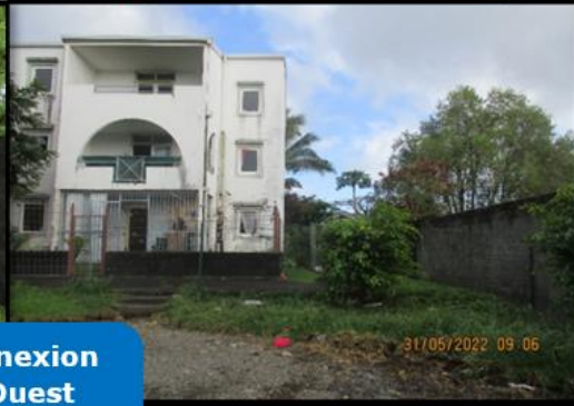
Au début des travaux
