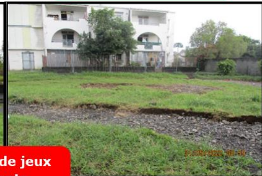
Au début des travaux
