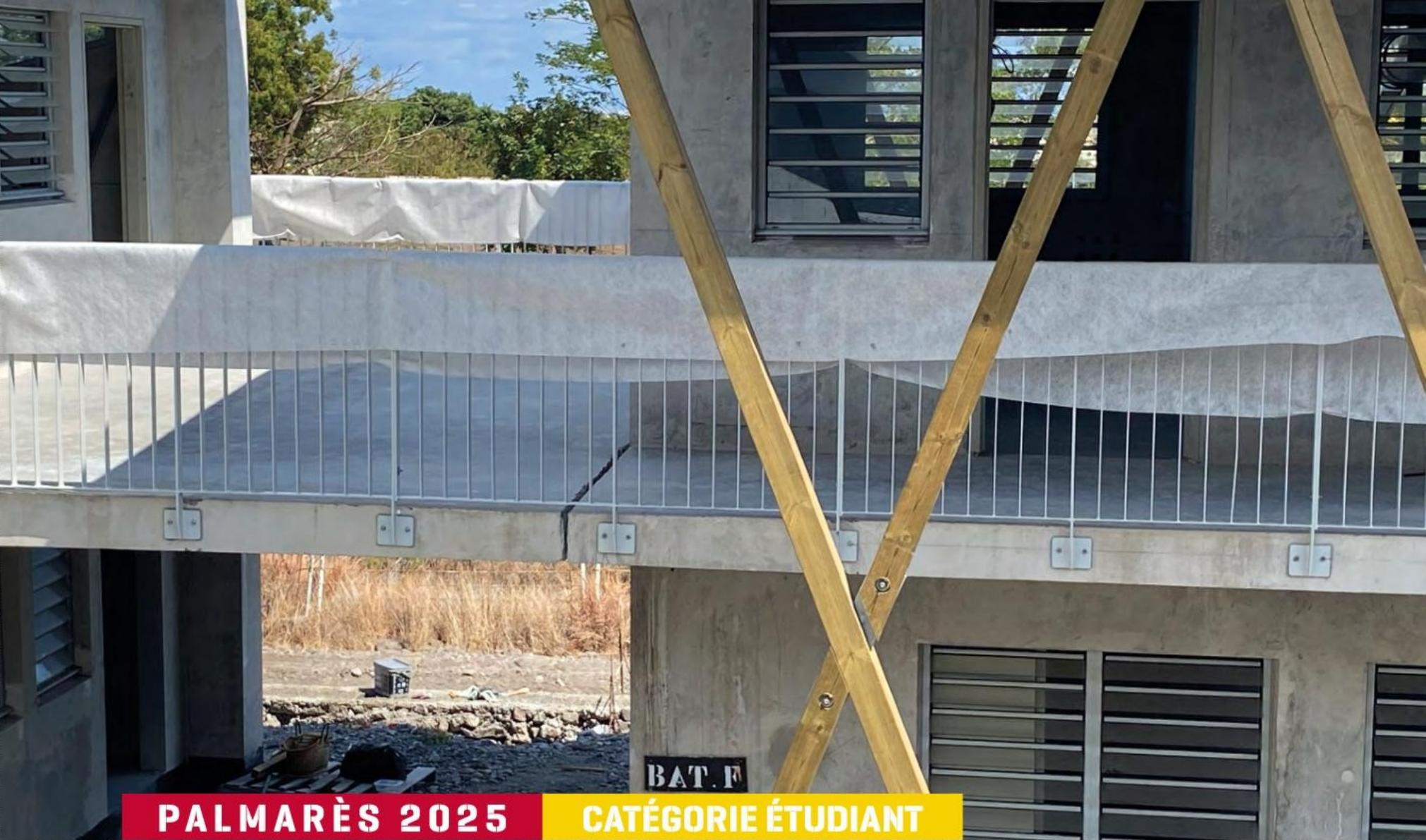
**Absence d'interruption du garde-corps au droit d'un joint de dilatation de la dalle.**
