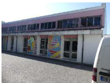
Entrée de l'établissement
