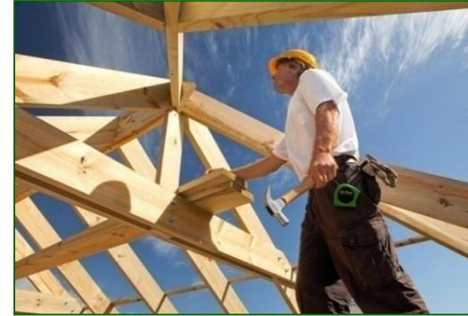
Le **charpentier bois** intervient en construction, réhabilitation, rénovation ou restauration de bâtiments et de locaux. Il réalise, en matériaux bois et dérivés, des charpentes mais aussi des ossatures
