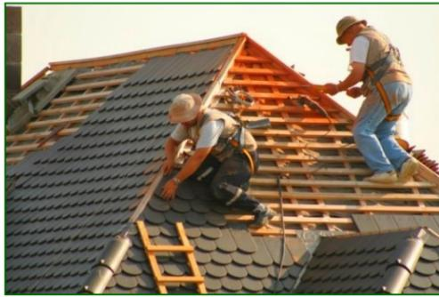
Le **Couvreur** assure l'**étanchéité des toitures**. Sur le chantier, le couvreur intervient après le charpentier. Il **réalise ou répare la toiture** dans un but de **protection** et éventuellement d'amélioration **esthétique** du bâtiment.
